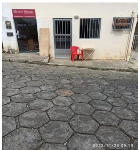
LOCAL DETERMINADO PARA O FINAL DA REDE DE DRENAGEM, E TAMBÉM UMA DAS CAIXAS
